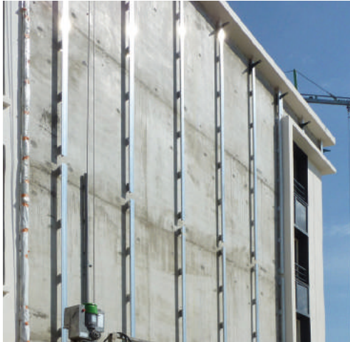
Implementation without insulation Mise en œuvre sans isolation
