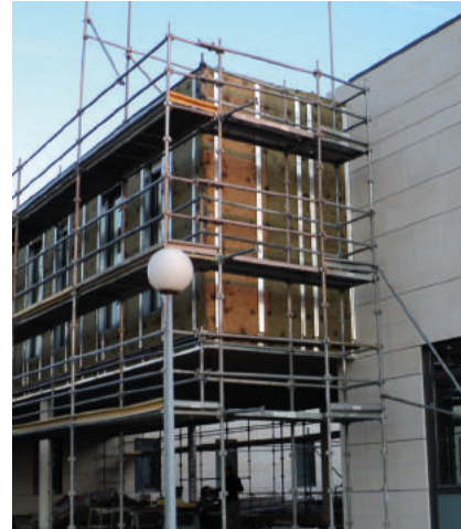
Implementation with insulation Mise en œuvre avec isolation
