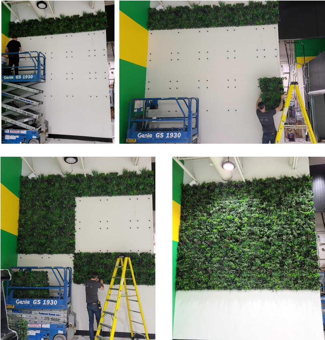
**26.** Si vous remarquez des espaces vides visibles sur le mur, vous pouvez retirer des plantes artificielles supplémentaires des morceaux de panneaux coupés et les attacher au support en fil avec des attaches de câble dans les zones vides.
