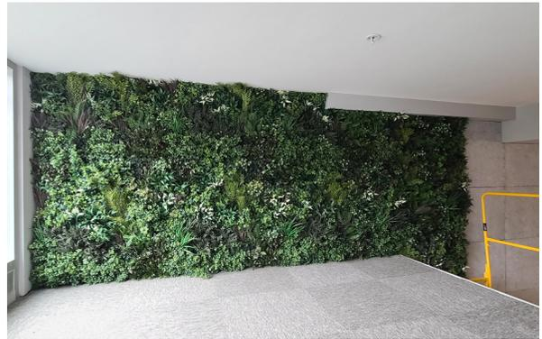
**36.** Répétez les étapes 30 à 33 pour chaque panneau de Faux Flora jusqu'à ce que votre mur soit entièrement assemblé. N'oubliez pas de vérifier continuellement que vos gabarits sont de niveau et correspondent à votre plan d'élévation au fur et à mesure.
