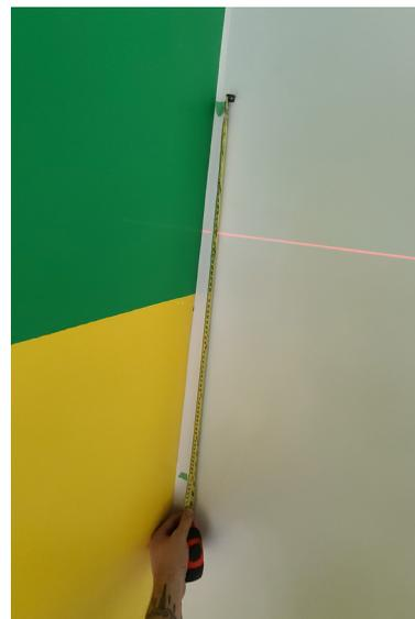
4. Continuez à mesurer le long du bord du mur, en marquant où les points d'ancrage seront placés selon votre plan d'élévation.
