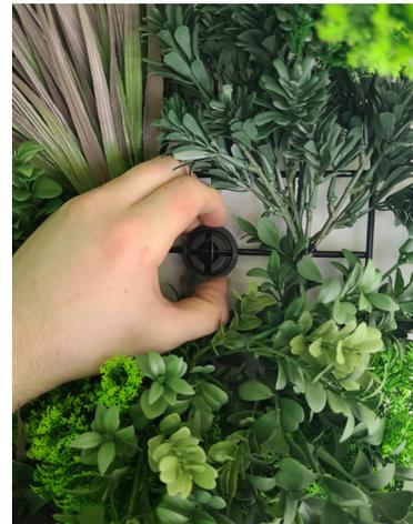
**22.** Vissez la bague en plastique fournie sur l'ancrage pour fixer le support en place.
