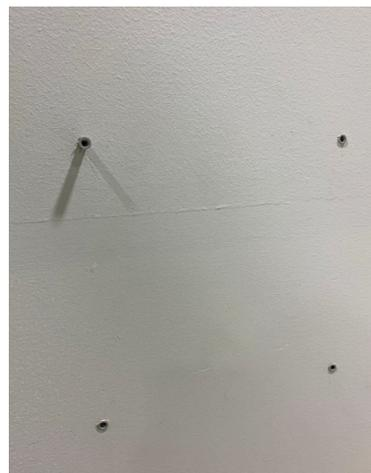
**14.** Insérez votre cheville pour cloison sèche et enfoncez-la à l'aide d'un maillet en caoutchouc jusqu'à ce qu'elle soit affleurante avec le mur.
