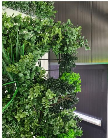
**20.** Pour installer un panneau, commencez par dégager les plantes autour de la zone où le support en fil métallique sera inséré dans les ancrages, comme indiqué sur votre plan d'élévation.
