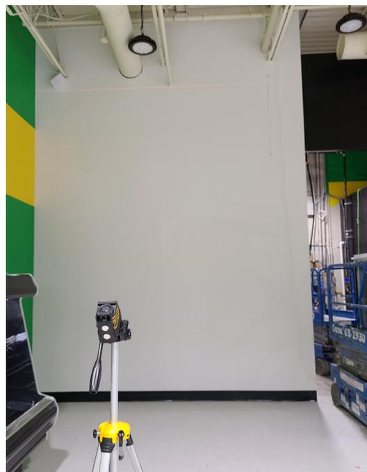
3. Mesurez et marquez le bord du mur où l'ancrage sera placé, comme indiqué sur votre plan d'élévation (habituellement 10 cm vers le bas, 2 carrés sur le treillis métallique).
