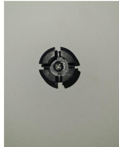
**17.** Assurez-vous de ne pas visser trop fort l'ancrage au mur. Un peu de jeu est nécessaire au cas où l'un de vos ancrages aurait été installé légèrement de travers.
