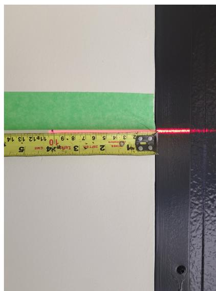
6. En vous déplaçant horizontalement le long du niveau laser, mesurez et marquez les points d'ancrage de votre plan d'élevation jusqu'à ce que la première rangée soit marquée.
