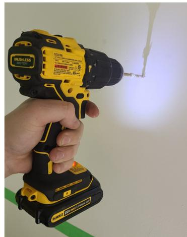
**13.** Utilisez une mèche légèrement plus petite que les chevilles pour cloisons sèches fournies et percez des trous exactement là où vous avez marqué. Il est important d'être précis lors de l'installation des ancrs car il y a très peu de jeu si une ancre est installée légèrement décalée.
