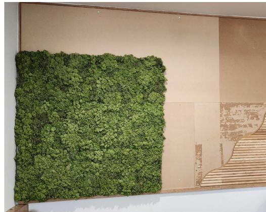
3. Continuez d'installer les panneaux en suivant le plan d'élévation.
