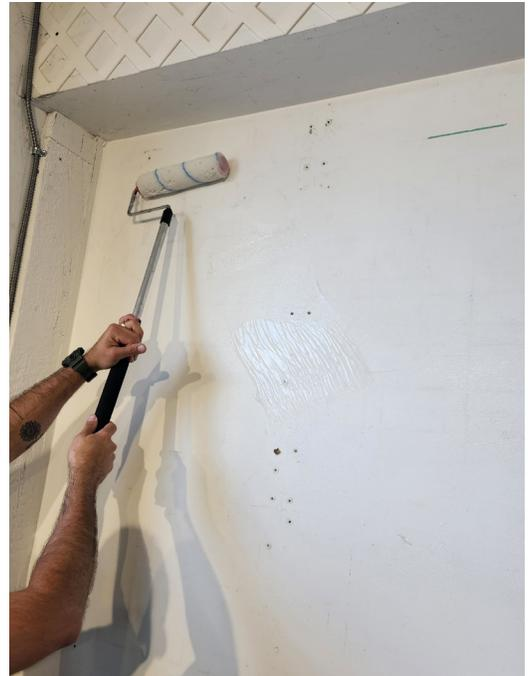
4. Alignez soigneusement la première bande avec une ligne de référence verticale (vous pouvez utiliser un niveau laser). Tenez-la par le haut et abaissez-la progressivement, en lissant avec un rouleau en plastique ou en caoutchouc ferme pour éliminer les bulles et les plis.
