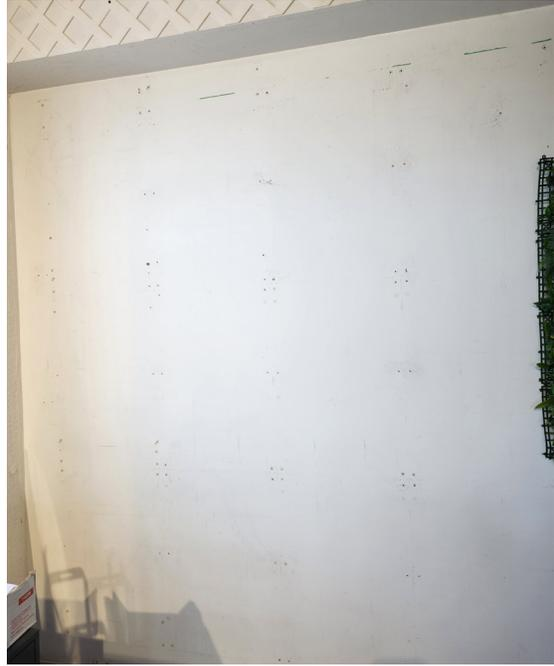
2. Mesurez la hauteur du mur et découpez des bandes de papier peint avec une marge supplémentaire (2 à 5 cm) pour un ajustement précis.
